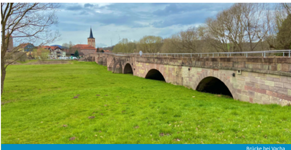
Brücke bei Vacha
